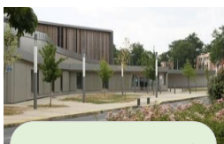
Gymnase Léonard de Vinci 6 avenue Léonard de Vinci Châtenay Malabry
