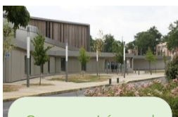
Gymnase Léonard de Vinci 6 avenue Léonard de Vinci Châtenay Malabry
