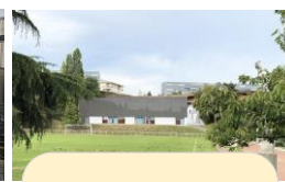
Stade municipal 260 avenue de la Division Leclerc Châtenay Malabry
